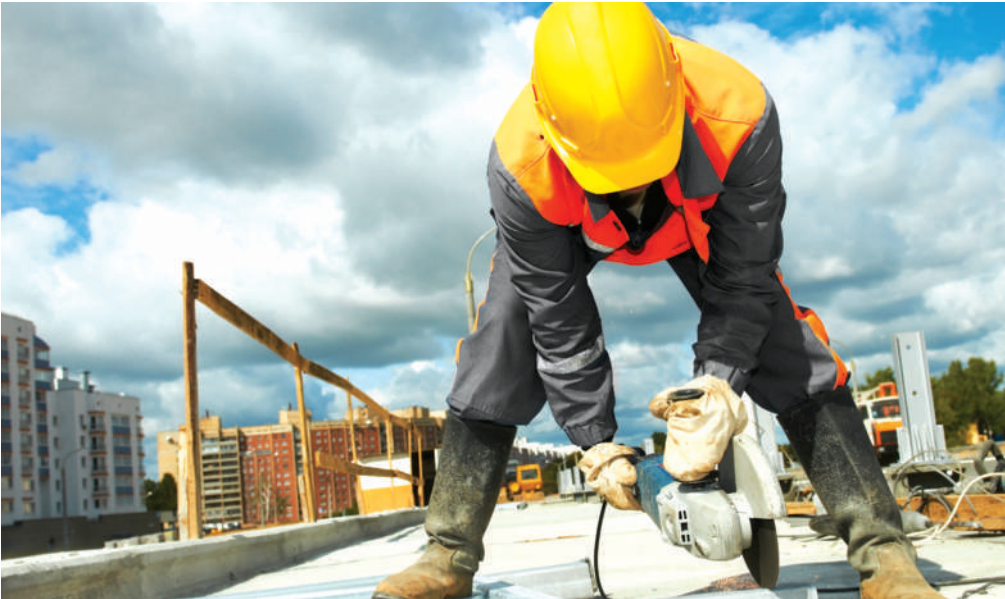
Csökkent az építőipari megrendelések állománya
